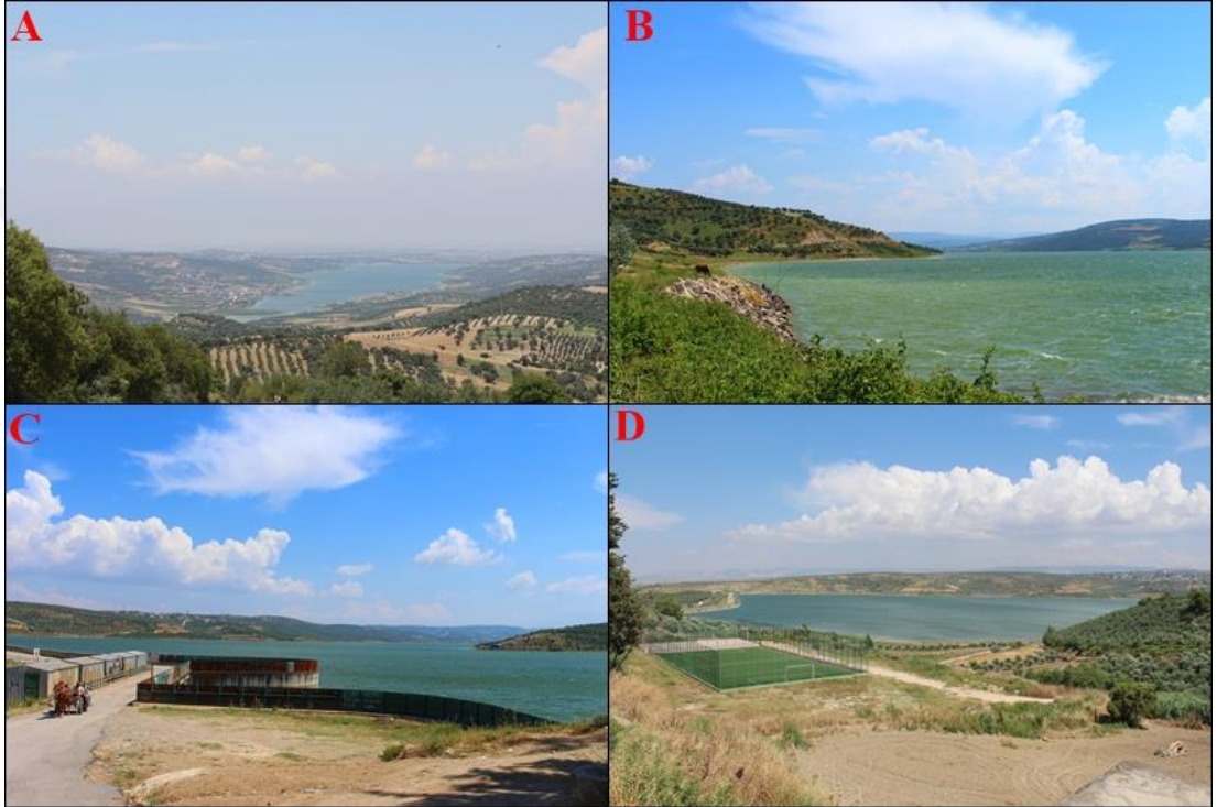
Foto 10: Yârseli Baraj Gölü (2018). A) Beyazçay Deresi üzerine kurulu olan Yarseli Barajının genel görünümü. B) Baraj kıyıları kesme kayalarla sınırlandırılmıştır. C) Toprak set şeklinde yapılan baraj suyunun acil durumlarda boşaltılması için açıl tahliye kapakları yer almaktadır. Yarseli sulama birliği tarafından yönetilen baraj çiftçilerin tarım arazilerini sulaması amacı taşımaktadır. D) Baraj çevresi ağaçlandırılarak sosyal amaçlı tesislerde yapılmıştır.
