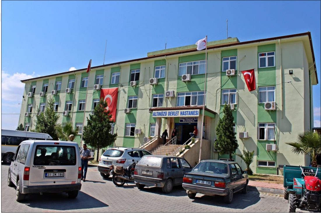
Foto 11: Altınözü Devlet Hastanesi (2018). Altınözü ve kırsal kesimine sağlık hizmeti veren Altınözü Devlet Hastanesinden bir görünüm.
