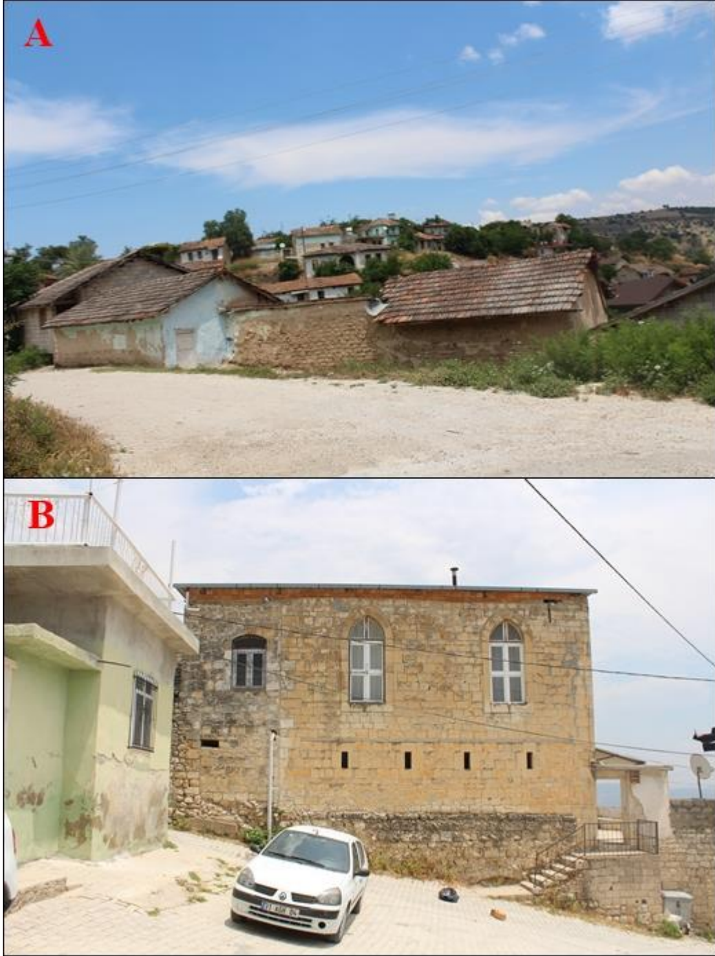
Foto 15: Altınözü İlçesinde Yer alan Meskenlerin Durumu (2018). A) Gözecik köyünde yer alan meskenler duvar malzemesi olarak kerpiç kullanılmış ve beşik çatı sistemi ile üzeri kapatılmıştır. B) Seferli köyünde tamamı taş malzemeden yapılmış olan bir mesken.
